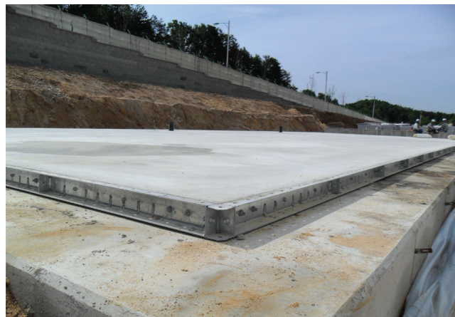
기초 콘크리트 평형패드
