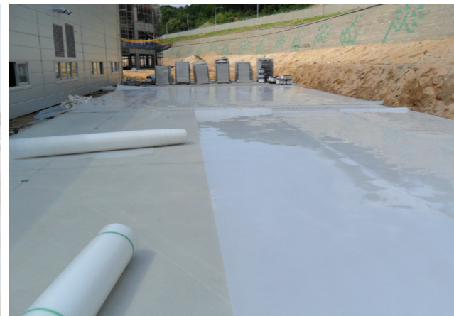
바닥부 PE SHEET 시공
